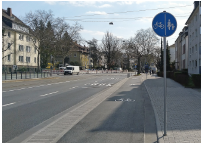
Neubau eines Radwegs in der Heidelberger Straße. Der Sicherheitstrennstreifen ist 75cm, der Radweg ist 2,30m breit.
